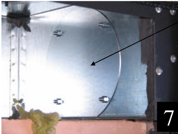
Nun die verzinkten Schutzdeckel in der Seitenwand des Rauchgasgehäuses entfernen. Ein Schutzdeckel innen, einer außen am Rauchgasgehäuse.
