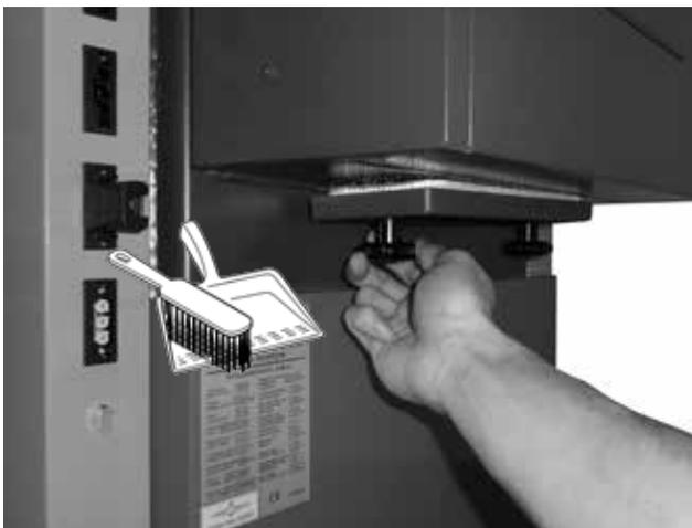
Veranschaulichung der Reinigung des Rauhabzuges im hinteren Bereich des Kessels.
