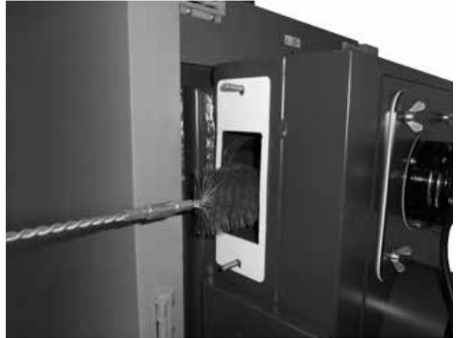
Veranschaulichung der Reinigung des Rauchkanals. Wird nach der Reinigung der Rohrwand über der Verbrennungskammer des Kessels durchgeführt
