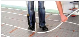
Das Rohr wird mithilfe der MAINCOR Haspel abgerollt und mit dem Tackergerät fixiert. Bei Fließestrichen müssen die Rohre in geringeren Abständen fixiert werden um ein Aufschwemmen zu verhindern. Vorgegebene Mindestbiegeradien sind zu beachten.
