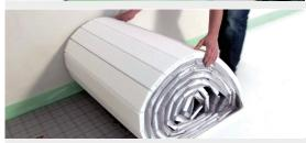
Die Dämmrolle wird auf der Unterdämmung ausgerollt. Anschliessend werden die Stöße sowie die Schürze des Randdämmstreifens mit Klebeband verklebt. Zwingend zu beachten sind die EN 4108 sowie das GEG.
