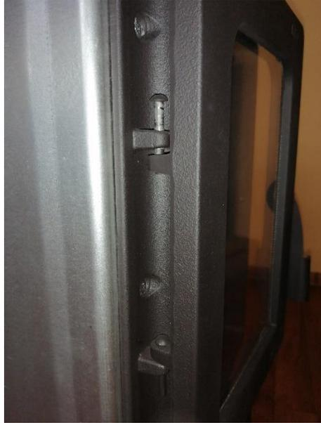
4. Ersetzen Sie die obere Niete durch einen Stift mit einem Sicherungsring an der Oberseite
