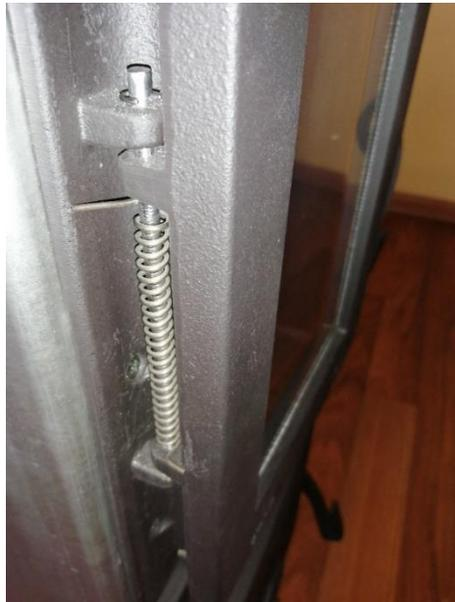
9. Position der Feder nach der Montage. Das längere Ende der Feder sollte auf dem Rahmen aufliegen, das gebogene Ende auf der Tür
