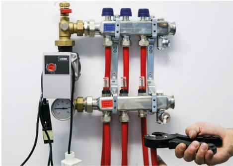
Rohr mit einem Rohrcutter ablängen
