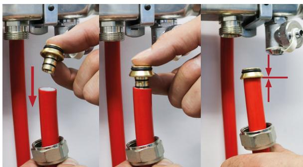
Messingtülle vollständig in das Rohr einstecken
