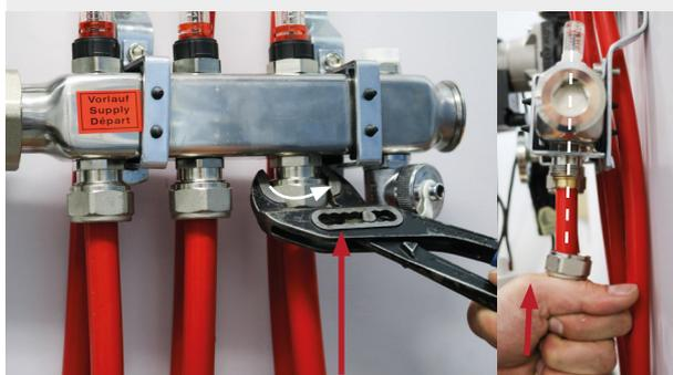
Finales Anziehen der Verschraubung mittels Zange oder Schraubenschlüssel
