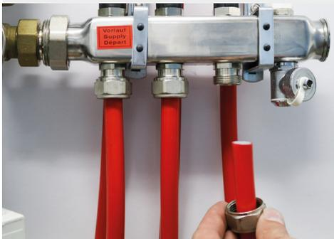
Überwurfmutter über Rohrende schieben
