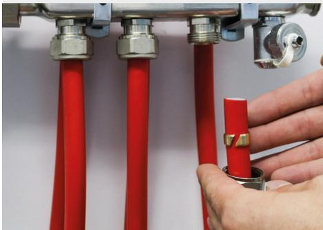
Schneidring ebenfalls über das Rohrende schieben
