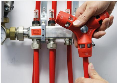
Rohr mit Universalentgrater entgraten
