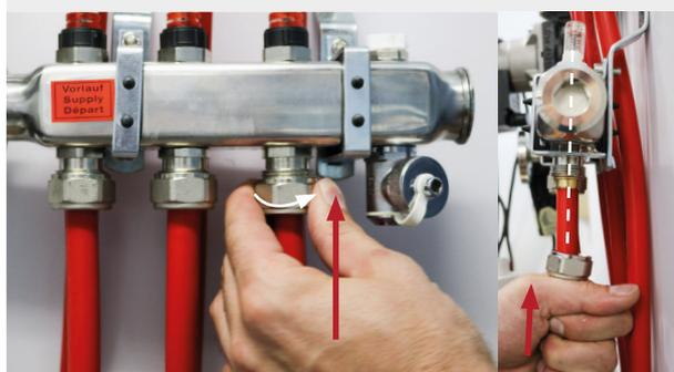
Überwurfmutter händisch auf das Gewinde schrauben
