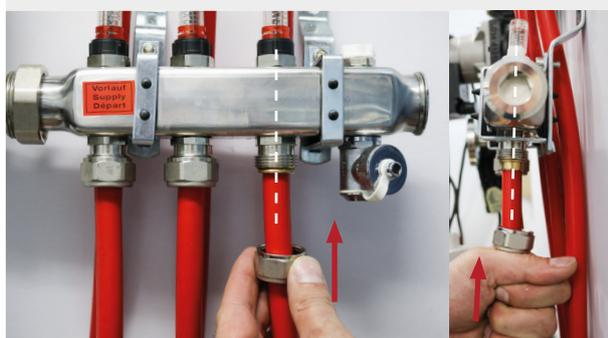
Rohr axial in den Verteiler einführen
