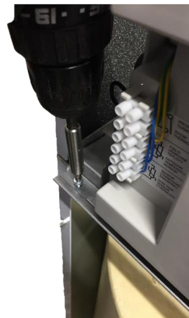
Befestigen Sie den Kesselrahmen hinten mit Hilfe der L-Profile am Rahmen des Warmwasserspeichers.
