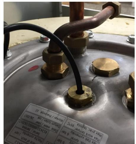
Schließen Sie den Temperaturfühler an die Klemmleiste des Kessels an. Anschließend muss die Regelautomatik des Kessels konfiguriert werden.
