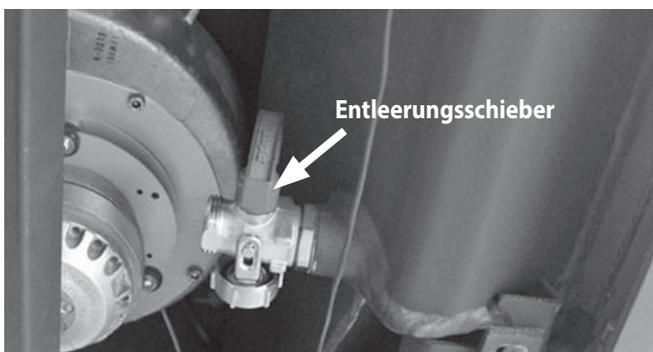
Über einen angeschlossenen Schlauch kann das im Geräteessel befindliche Wasser abgeleitet werden.
