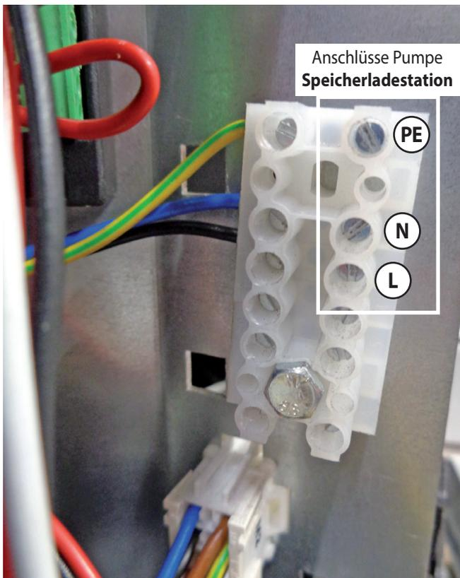
Bei der Verlegung des Steuerkabels vom Gerät zur **Speicherladestation** ist das Steuerkabel durch eine der Zugentlastungen im Bereich des Netzsteckers zu führen und die Zugentlastung ordnungsgemäß zu montieren.
