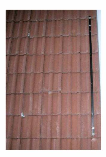
Bei dieser Befestigungsweise müssen die Dachhaken entsprechend den Kollektorrahmen und den Dachsparren montiert werden.
