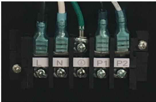
Position L, N and
