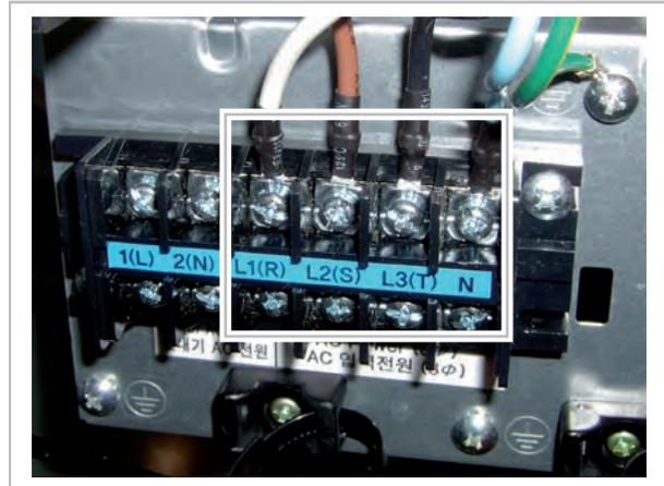
Abb. 10: Anschlussklemme Außenmodul WKF/WKF-compact 180
