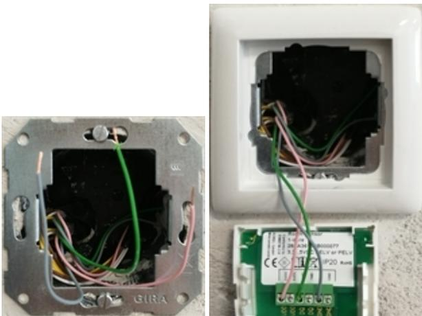
Montieren Sie den Sensor an geeigneter Stelle.
