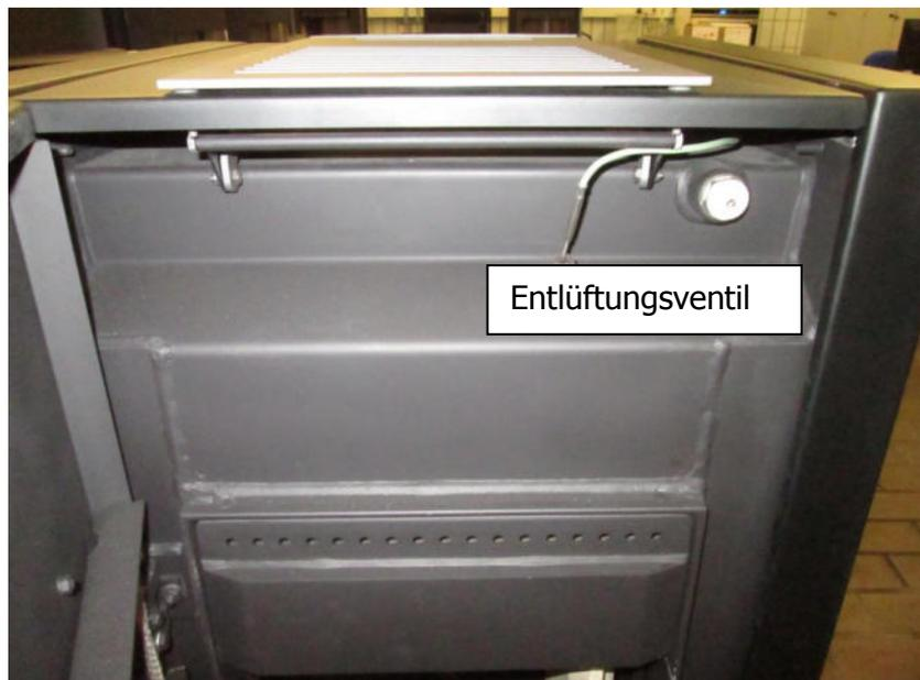
gleiche Menge an Luft aufzunehmen wie kaltes Wasser. Es wird somit die „übrige“ Menge an Luft im Wärmetauscher des Gerätes ausgeschieden. Dies ist ein vollkommen normaler Physikalischer Vorgang. Um die Luftmenge der gesamten Anlagen Wasservolumen zu „entlüften“ ist es notwendig dass jedes Wasserteilchen auf maximal Temperatur erhitzt wird.
