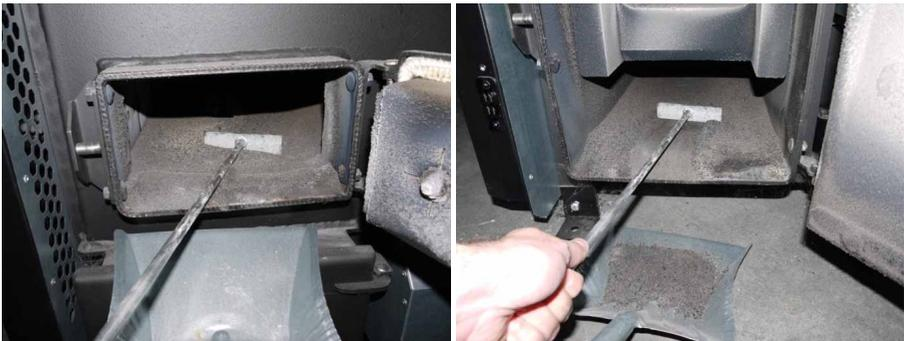
**Bild 41** Reinigung des Füll- und Verbrennungsraumes
