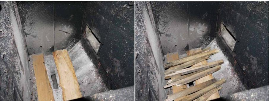
**Bild 18 Nachlegen von Holz bei automatischer Zündung**
