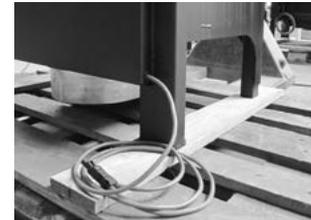
Innerhalb der Kaminverkleidung ist eine Leitungsreserve von mind. 50 cm vorzuhalten, so dass bei Revisionsarbeiten der Rollentürkontaktschalter nach oben aus dem Türschweller ausgebaut werden kann.
