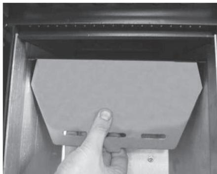
Fig. 16: rotación de la placa cortafuego
