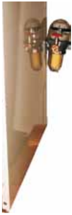
Ölfiler außen am Heizkessel montiert
