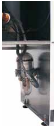
Ölfiler im Heizkessel montiert
