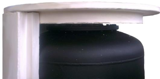
5. Den PVC-Mantel um die PU-Hartschalen legen und mit dem Reißverschluss verschließen.
